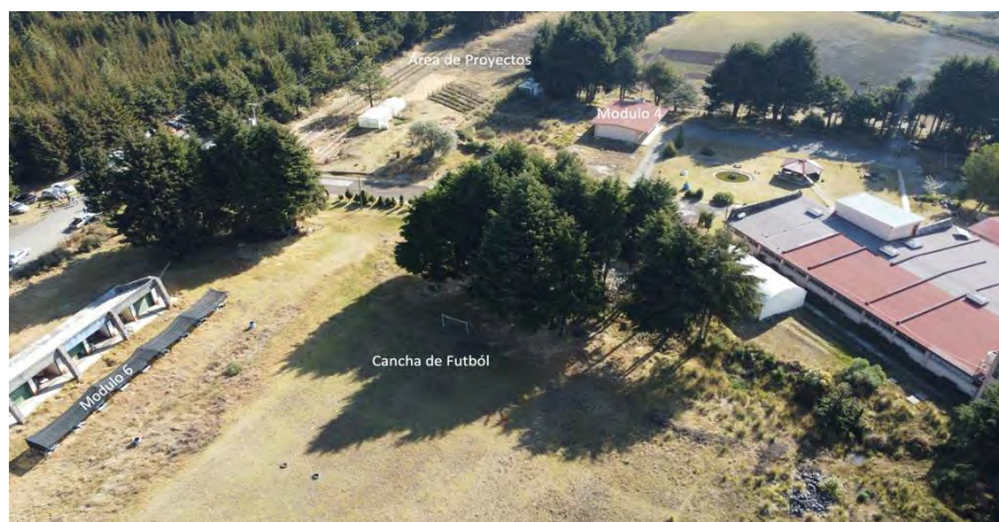
Fig. 2. Modulos de infraestructura de la Escuela Preparatoria Comunitaria de Tres Marías (Modulos 4, 6 área de proyectos y Cancha de Fútbol).
